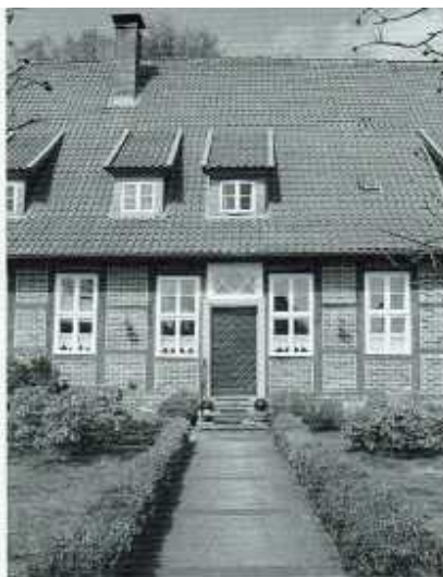
6 Seiteneingang des Pfarrhauses, jetzt Haupteingang der Pfarrwohnung (Foto: Kohnke-Löbert)
